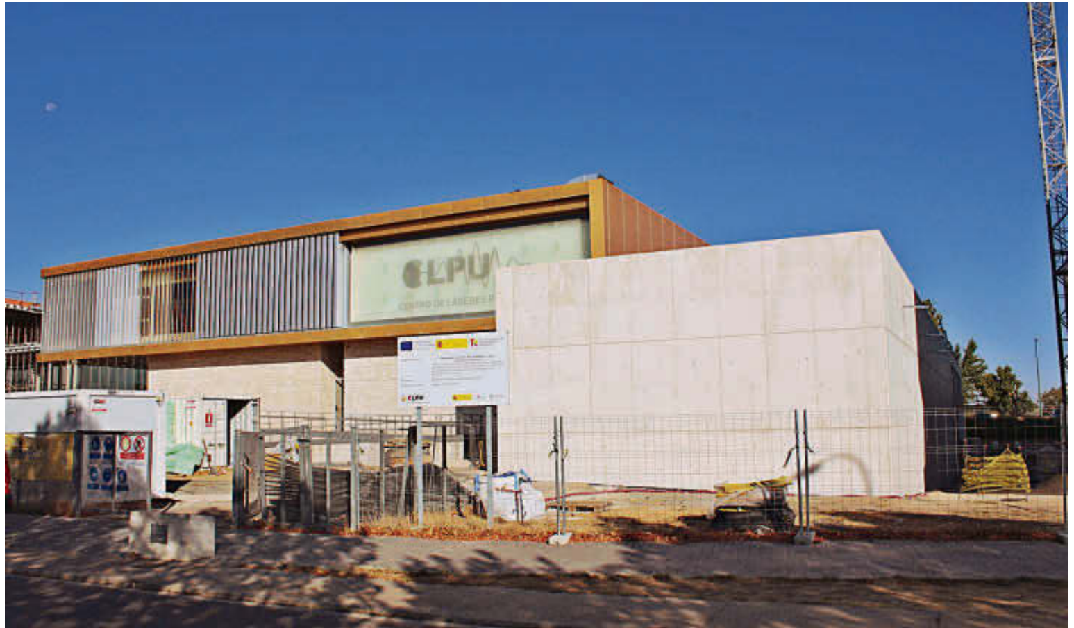
Obras de ampliación que se están llevando a cabo en el Centro de Láseres Pulsados.
