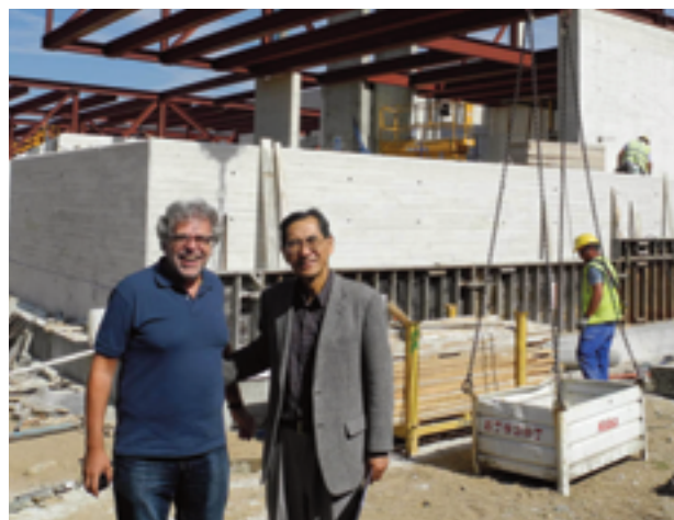
Luis Roso (i) junto al físico japonés Toshiki Tajima durante la visita que éste realizó a las obras de construcción de la sede del Centro.
