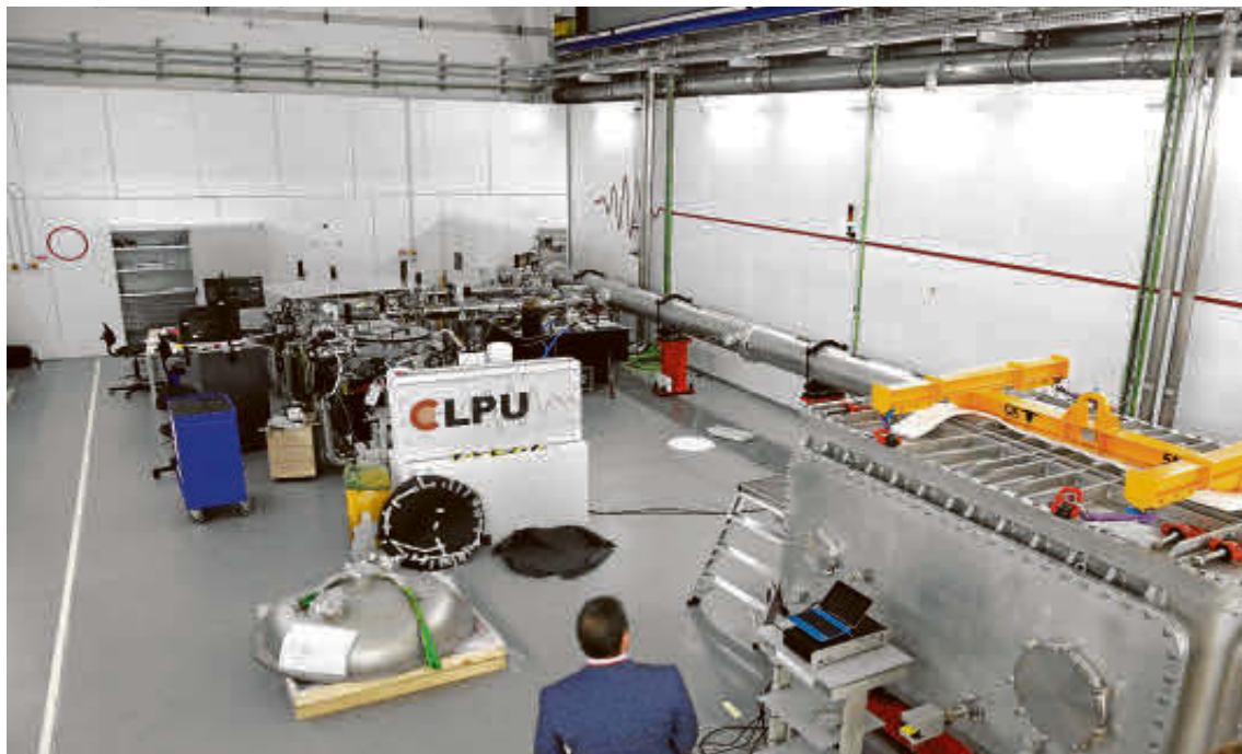
Últimos equipos instalados en el Centro de Láseres Pulsados de Salamanca, ubicado en Villamayor. | ALMEIDA
