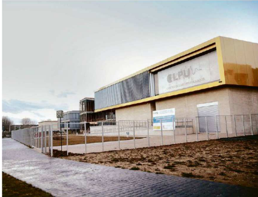
Exterior del edificio que alberga el Centro de Láseres Pulsados. | BARROSO
