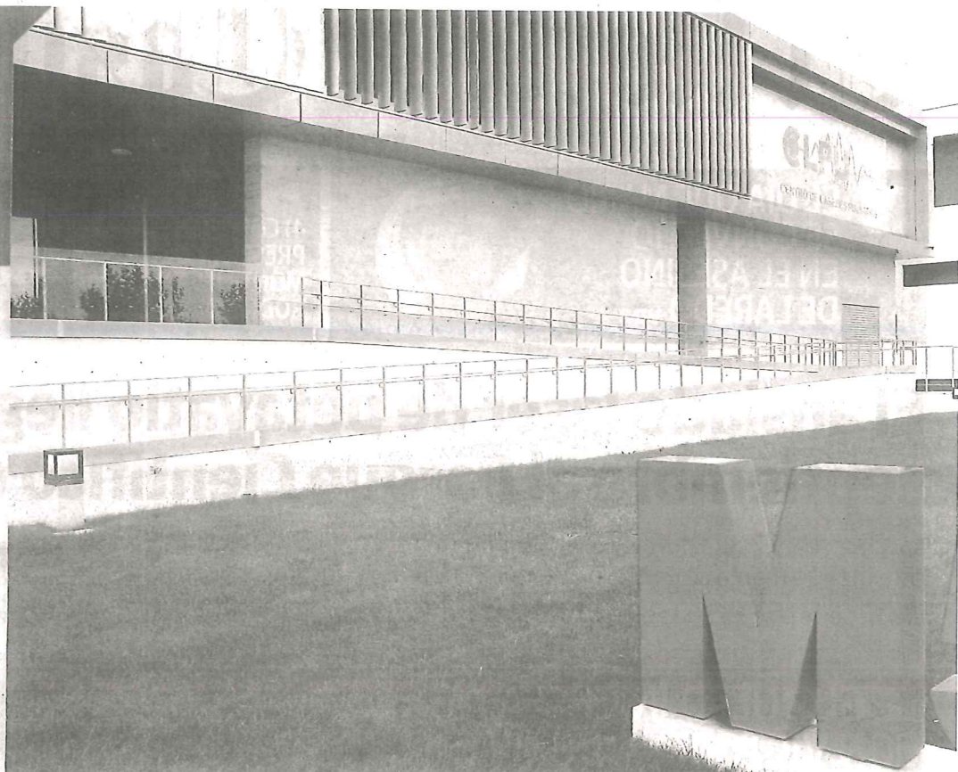
Imagen del edificio M5 del parque científico de la Universidad de Salamanca en Villamayor, en el que se instalará el láser de petavatio. :: AL
