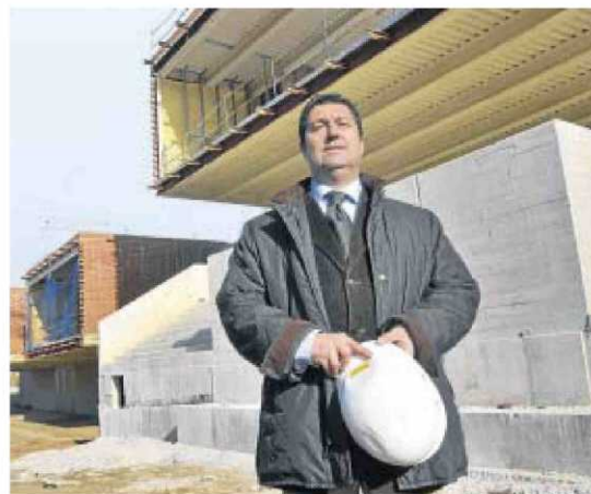
Pedro García, gerente del centro, en el exterior de las obras.
