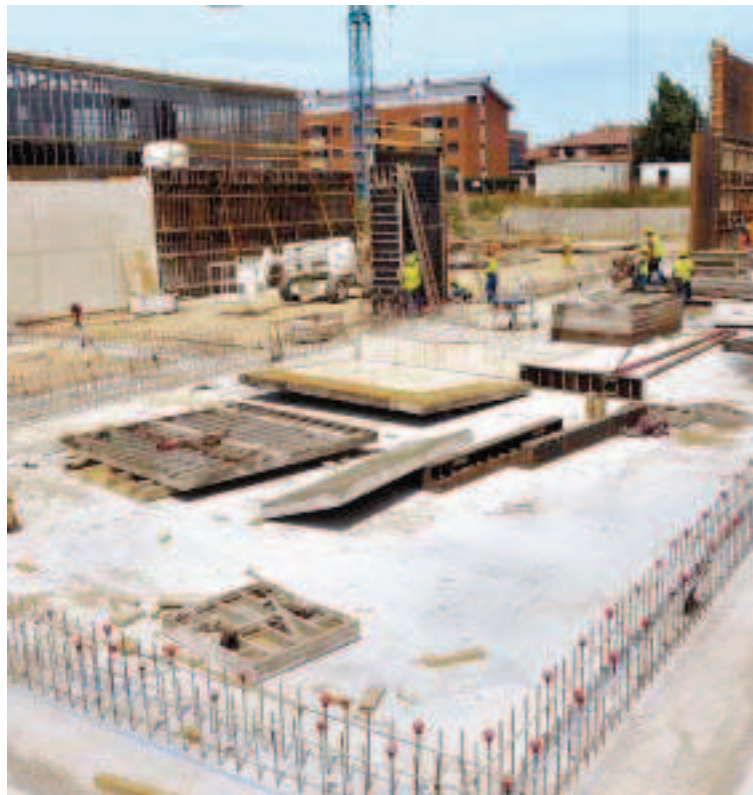
Espacio en el que va la gran losa sobre la que se ubicará el láser.
