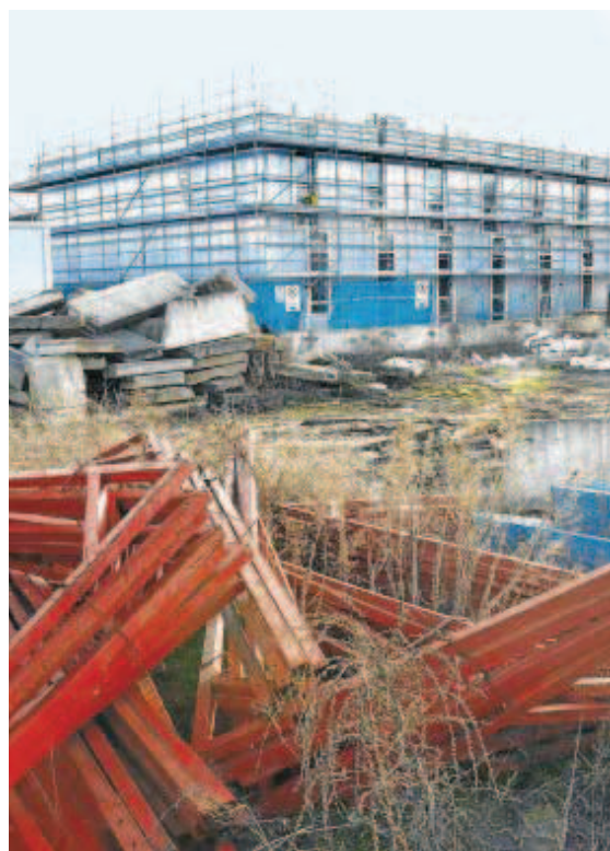
Obras del edificio de la Bioincubadora situado junto al CIALE. /FOTOS: BARROSO
